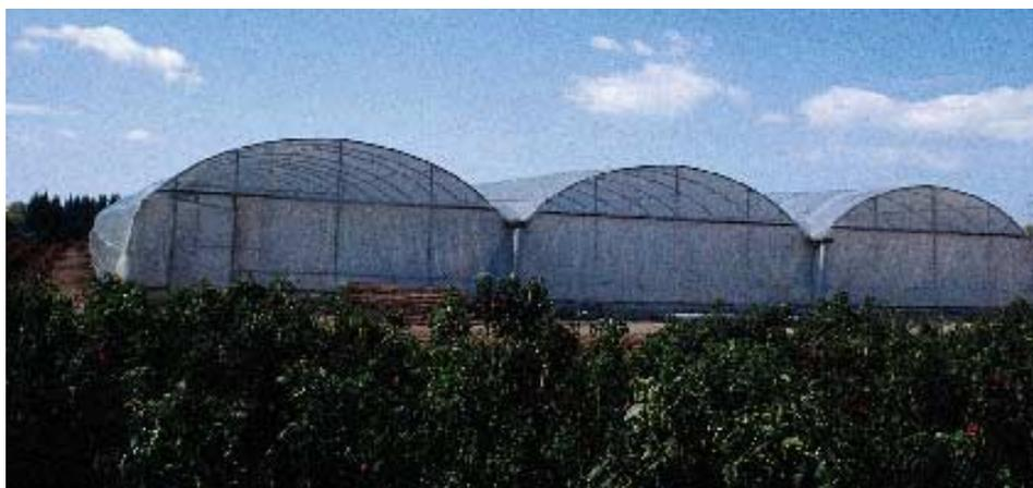
7. Multitúnel con la cubierta plástica ya retirada.
